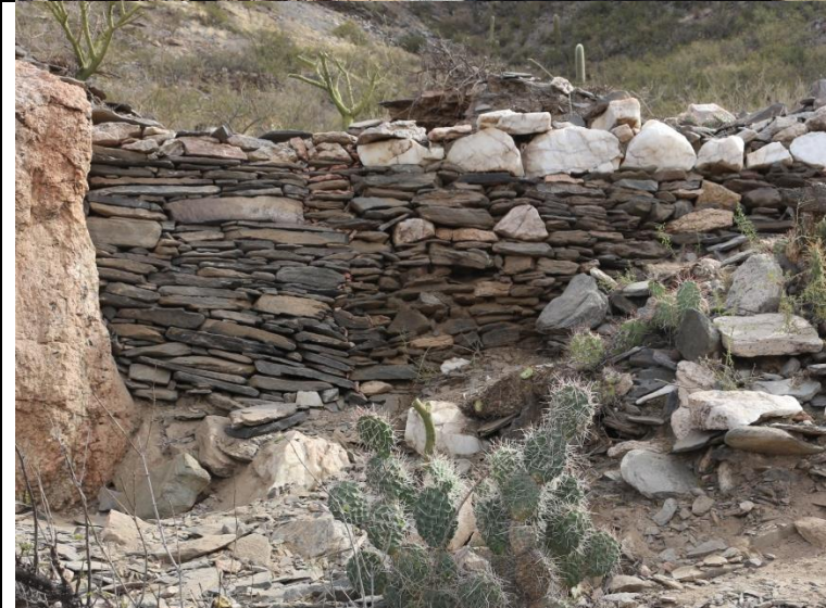
Muro plaza 111 despues de la intervención.
