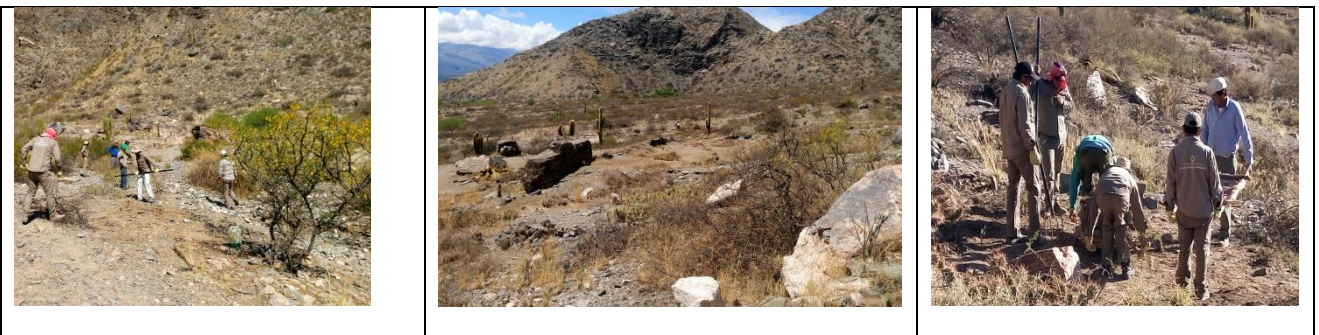
Poda y recorte controlado de vegetación en los muros y dentro de los recintos sector 8
