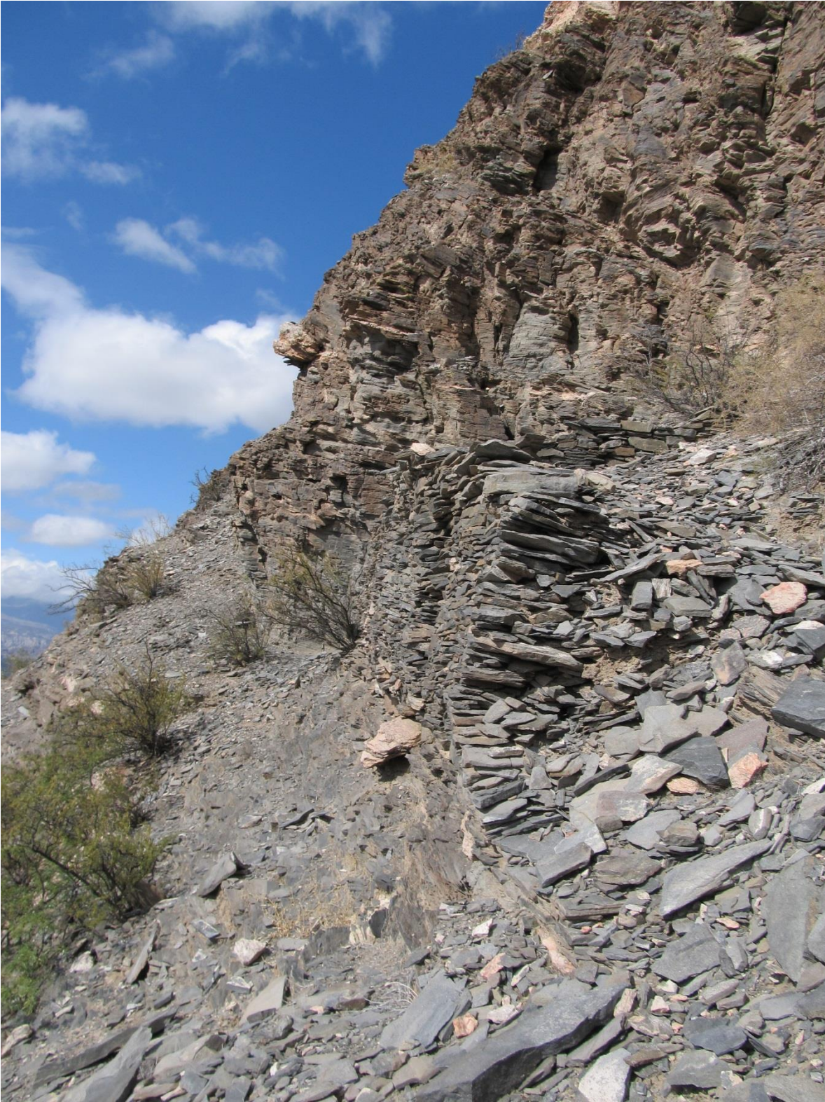
Muros en peligro inminente, Quebrada del Puma.
