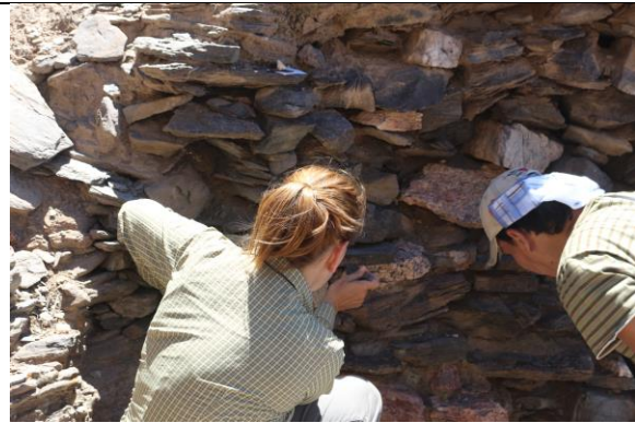
Muro S Estructura 270 integración de lajas y fijación de base
