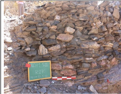
Muro S Estructura 270 base descalzada
